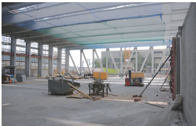
Die Tragkonstruktion des Gebäudeteils über der Eiskralle mit der Dreifach-Sporthalle und der Athletikhalle ist ein Stahlbau.
